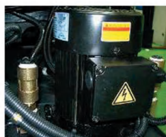
冷却液箱电机 停止改为关闭
